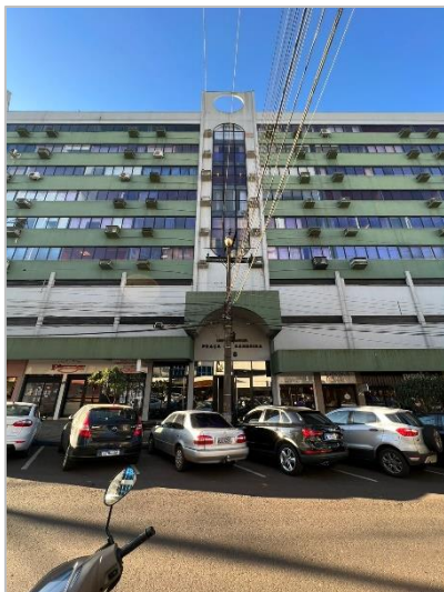
Foto 1 - Vista geral da edificação
